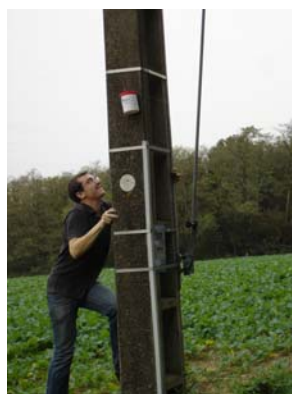
Photo n°1 : pose d'un tube passif
