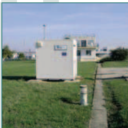
Station de surveillance de Bourges Sud.
